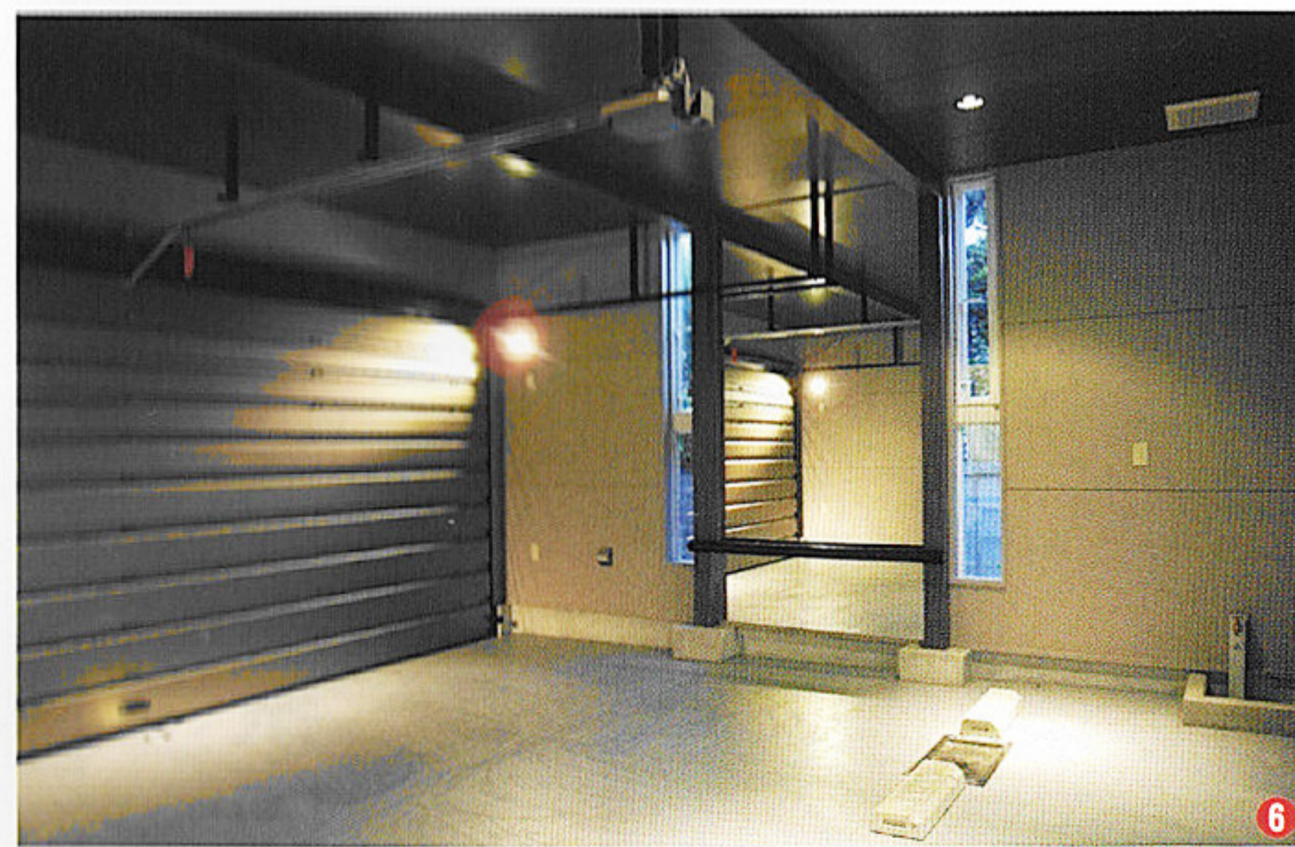
電動のオーバースライダー・センサー付スポットライト・塗床・大容量の排気ダクトなど、かつ広いだけでなく機能も充実したガレージ
