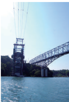
マリナを出て天草五橋のひとつ「天門橋」の下を通過して島原湾へ。新天門橋を架ける工事の真っ最中だ。
